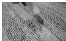
↑カッターナイフでカットしている状態
